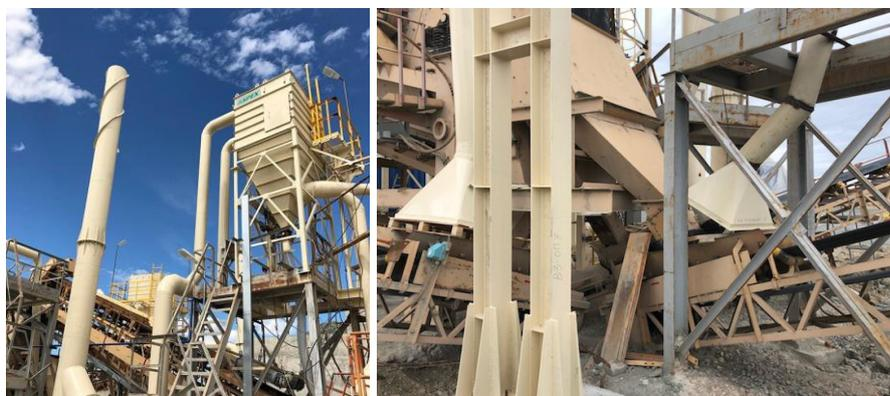
Рисунок 1. Фото ДСК «Кредмаш» модернизированного и дооснащенного системой аспирации Aspex на предприятии Башкирская медь, УГМК-Холдинг
